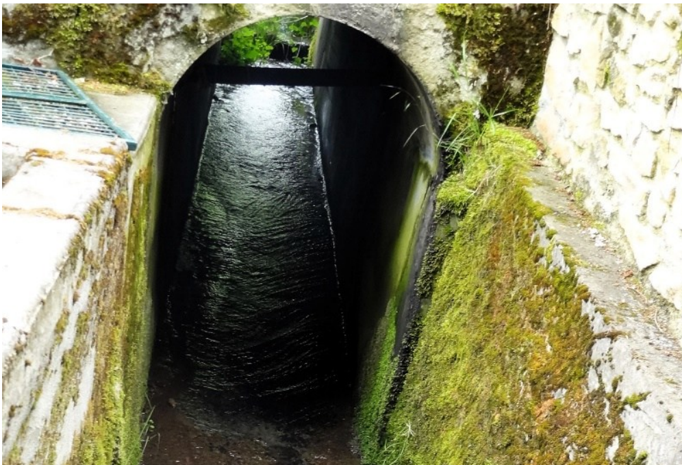
Le pont et la canalisation de la source - Les Godas
